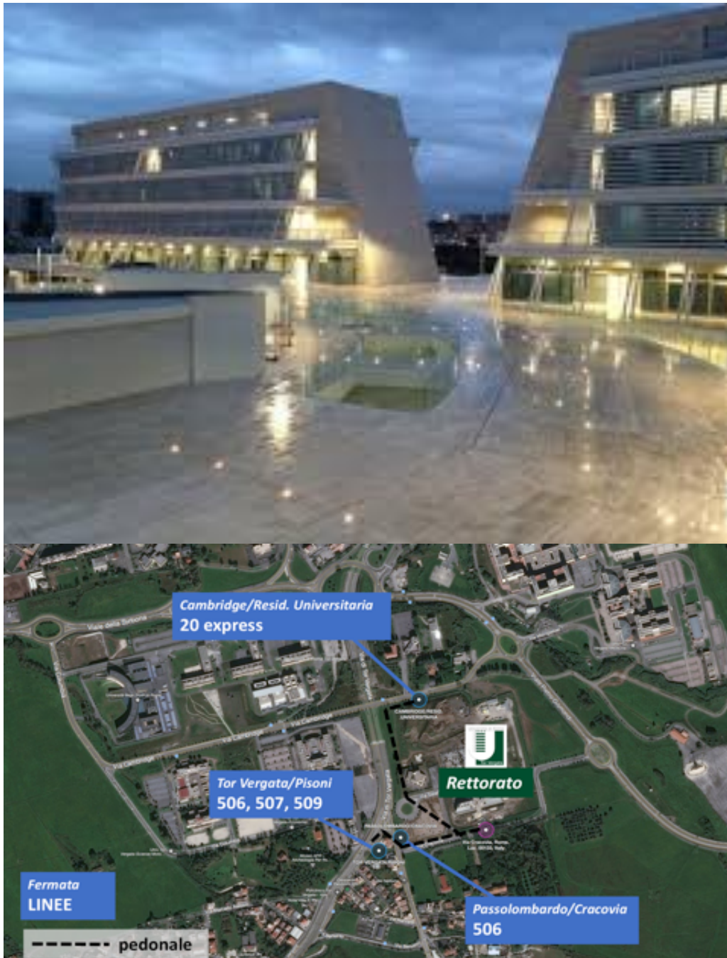
Il nuovo Rettorato nel Campus di UTOV, e vista area del Campus
