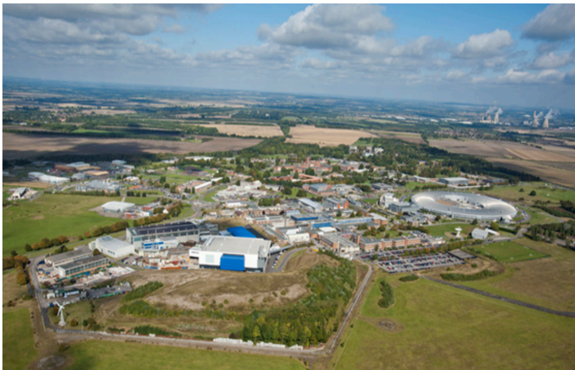
Figura I. Nella foto l'Infrastruttura di Ricerca ISIS del Science and Technology Facilities Council (STFC) nell'Oxfordshire (UK). ISIS@MACH offrirà accesso a utenti pubblici e privati a un insieme di servizi e analisi con strumentazione presso il Campus di Tor Vergata e agirà come NEUTRON GATE per le caratterizzazioni effettuate presso ISIS in UK, una offerta completa ed unica nel suo genere, di interesse non solo nell'area laziale ma anche a livello nazionale ed internazionale.
